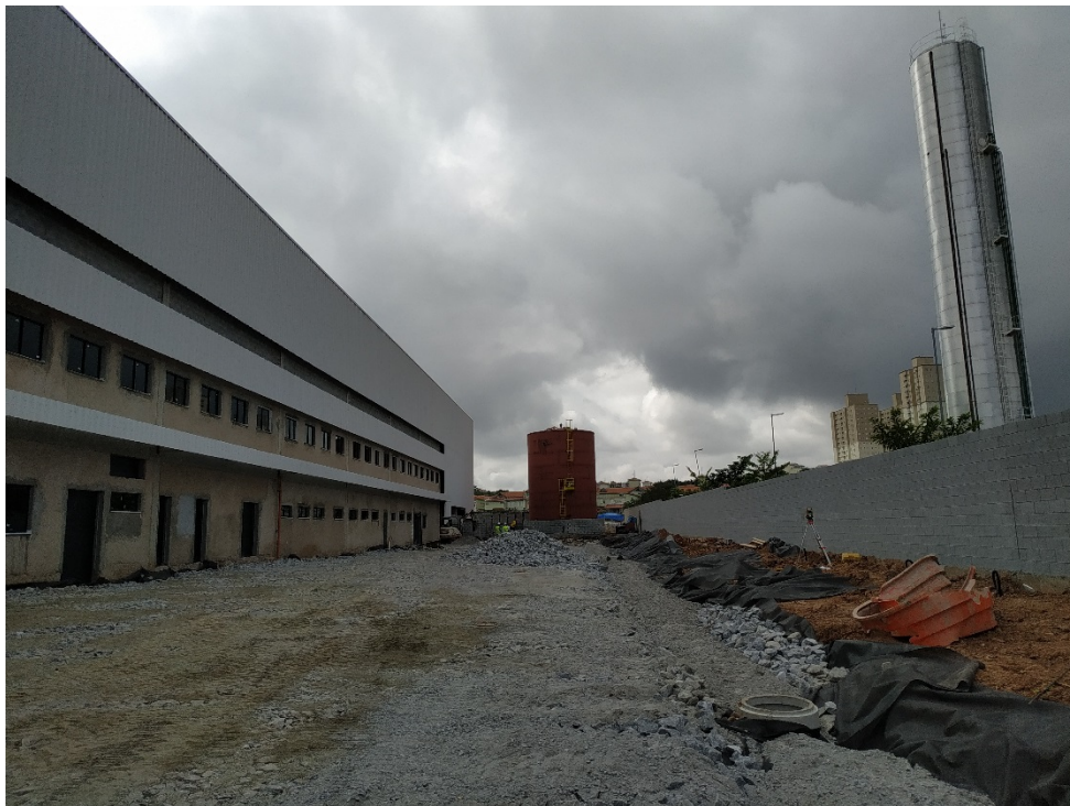
VISTA LATERAL DO GALPÃO
