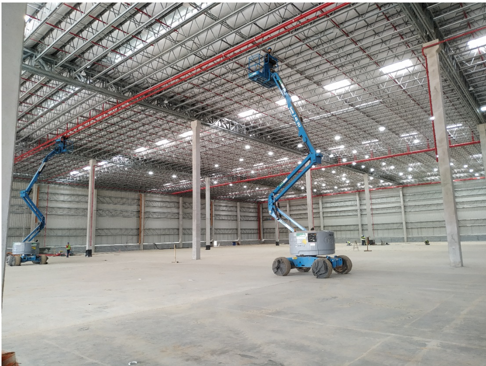
VISTA INTERIOR DO GALPÃO
