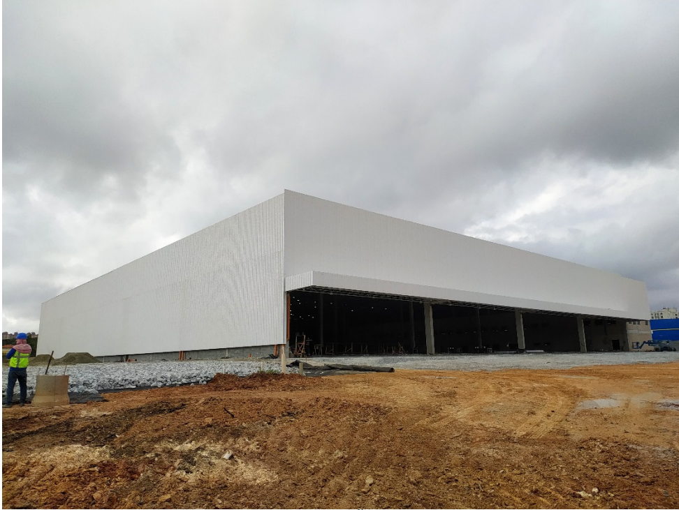
VISTA DO GALPÃO PRINCIPAL
