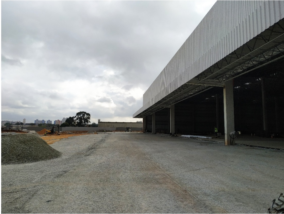
VISTA ENTRADA PRINCIPAL DO GALPÃO
