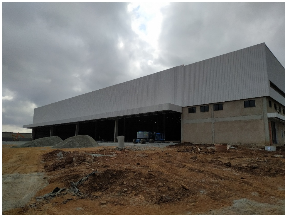
FACHADA PRINCIPAL DO GALPÃO
