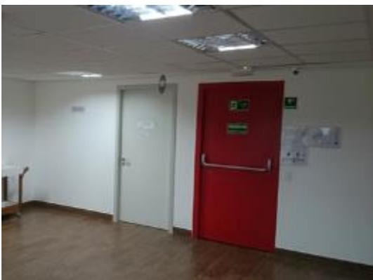
*Porta de emergência com fechaduras anti-pânico*
