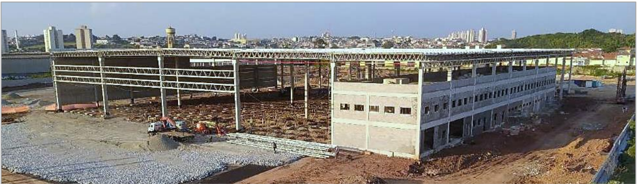
Imóvel FEMSA: Centro de Distribuição – visão externa da obra.
