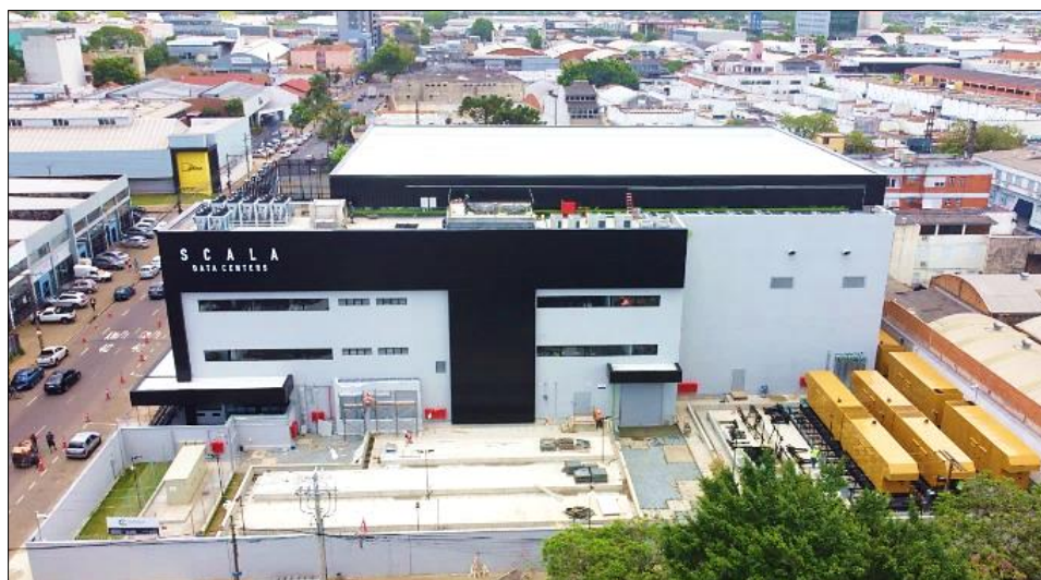
Imóvel Scala: vista da fachada e do entorno do Imóvel, que teve sua construção finalizada em novembro de 2023.
