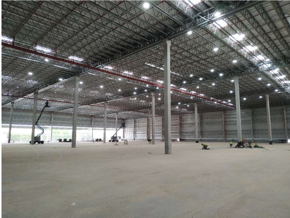
VISTA INTERIOR DO GALPÃO
