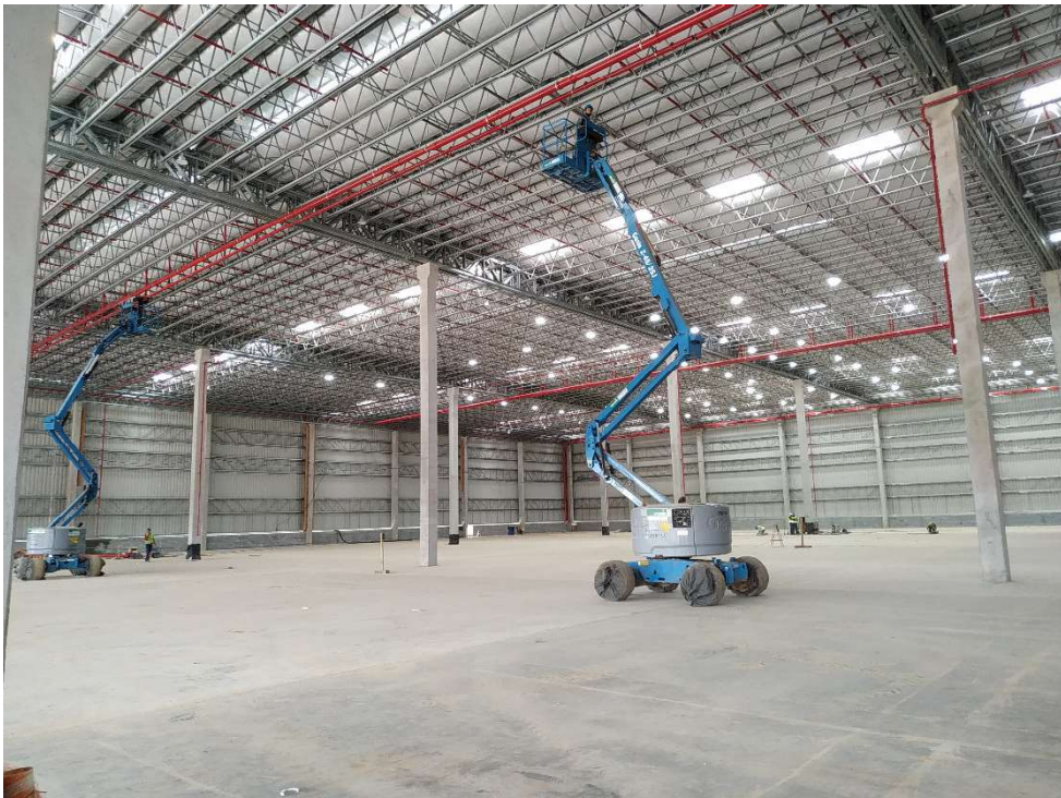
VISTA INTERIOR DO GALPÃO
