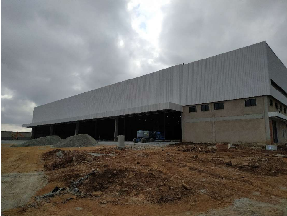
FACHADA PRINCIPAL DO GALPÃO
