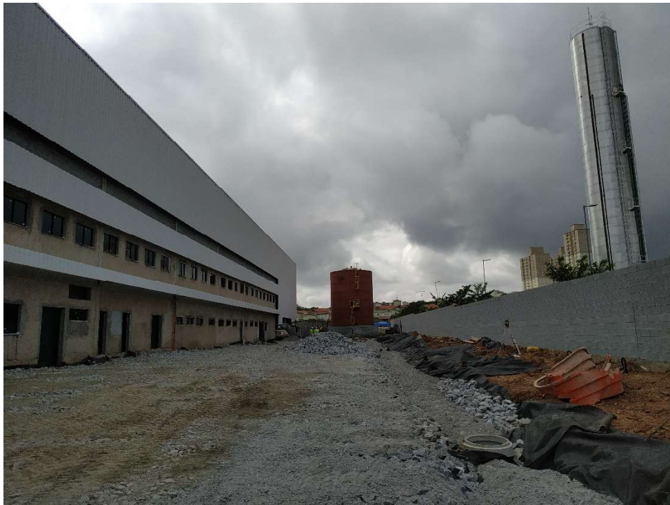
VISTA LATERAL DO GALPÃO
