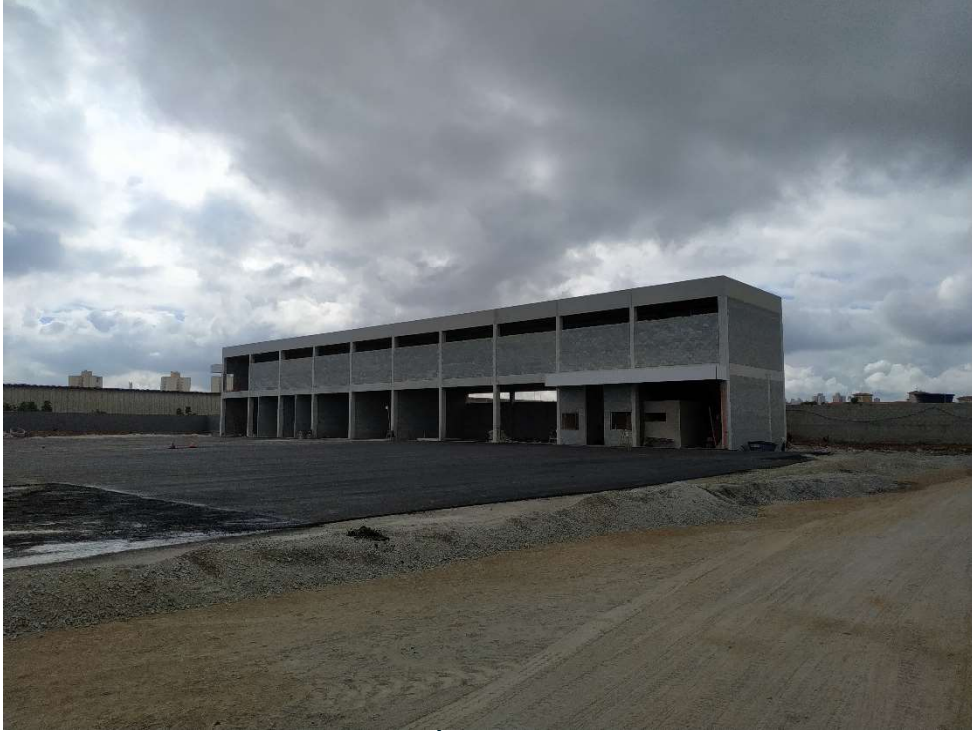
PRÉDIO DE APOIO
