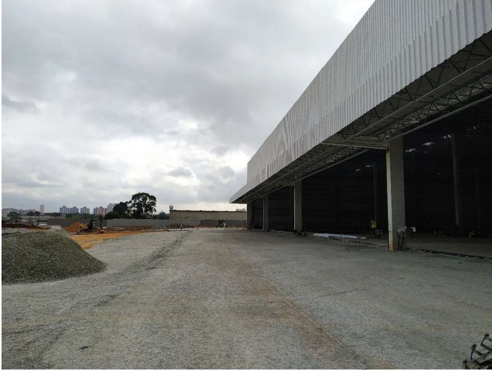
VISTA ENTRADA PRINCIPAL DO GALPÃO
