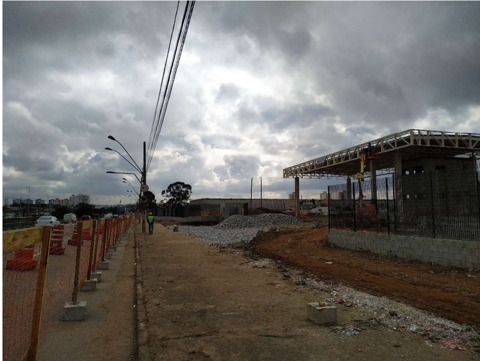
VISTA PARA AVENIDA DOS ESTADOS – SENTIDO NORTE
