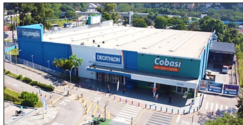
Imóvel Raposo: vista da fachada onde funcionam as operações da Decathlon e da Cobasi, localizado na Rodovia Raposo Tavares, nº 6.008, São Paulo/SP.
